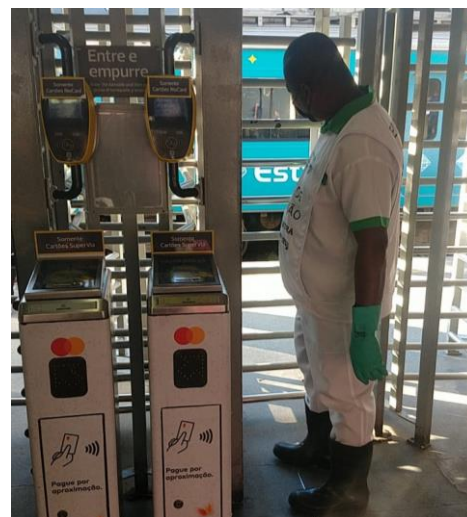
Figura 5.15 SuperVia – Estação Campo Grande – 04/01/2021
